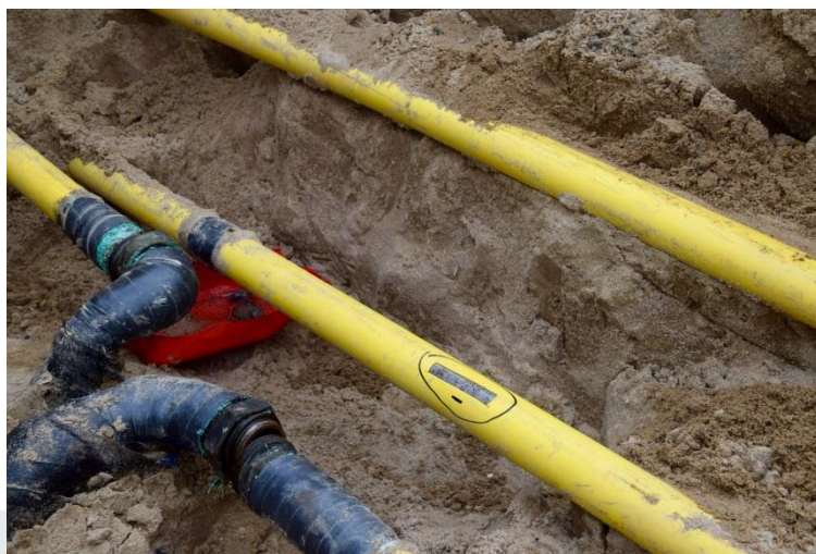
Foto: voorbeeld leidingwerk tank
