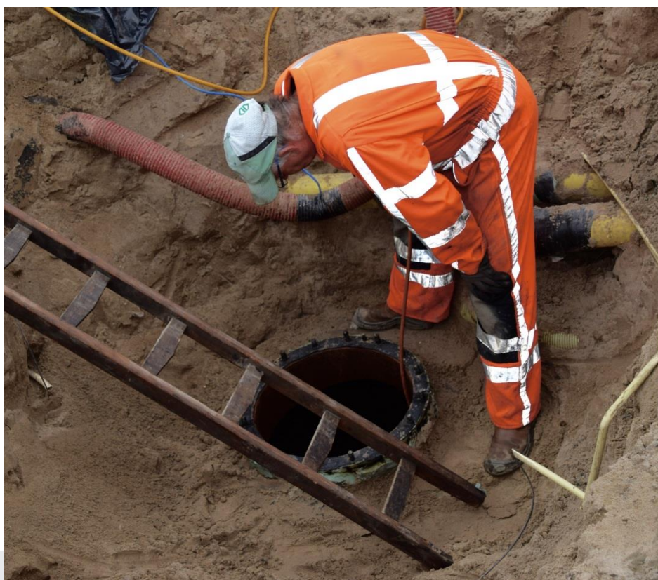
Foto: Mangat tank
